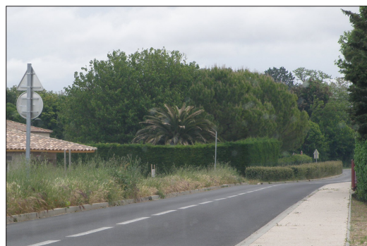
Photo 3 : trottoir facilitant la déambulation piétonne
