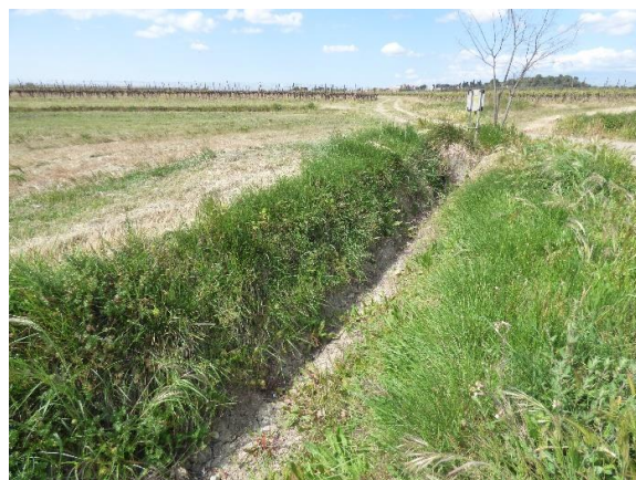
Canal d'écoulement des eaux de pluie (Estang)
