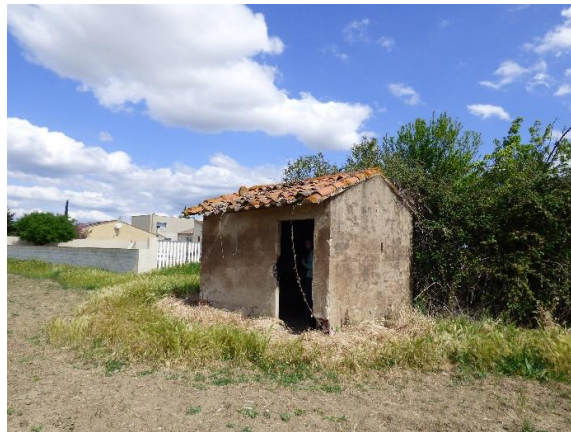
Petit bâti abandonné (Las Faïsses)
