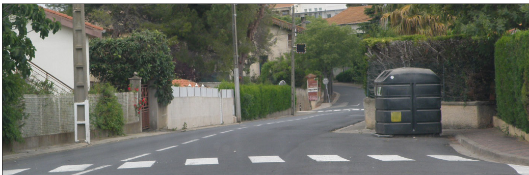
Photo 1 : une voirie à Abeilhan qui ne laisse pas de place aux cheminements piétons
